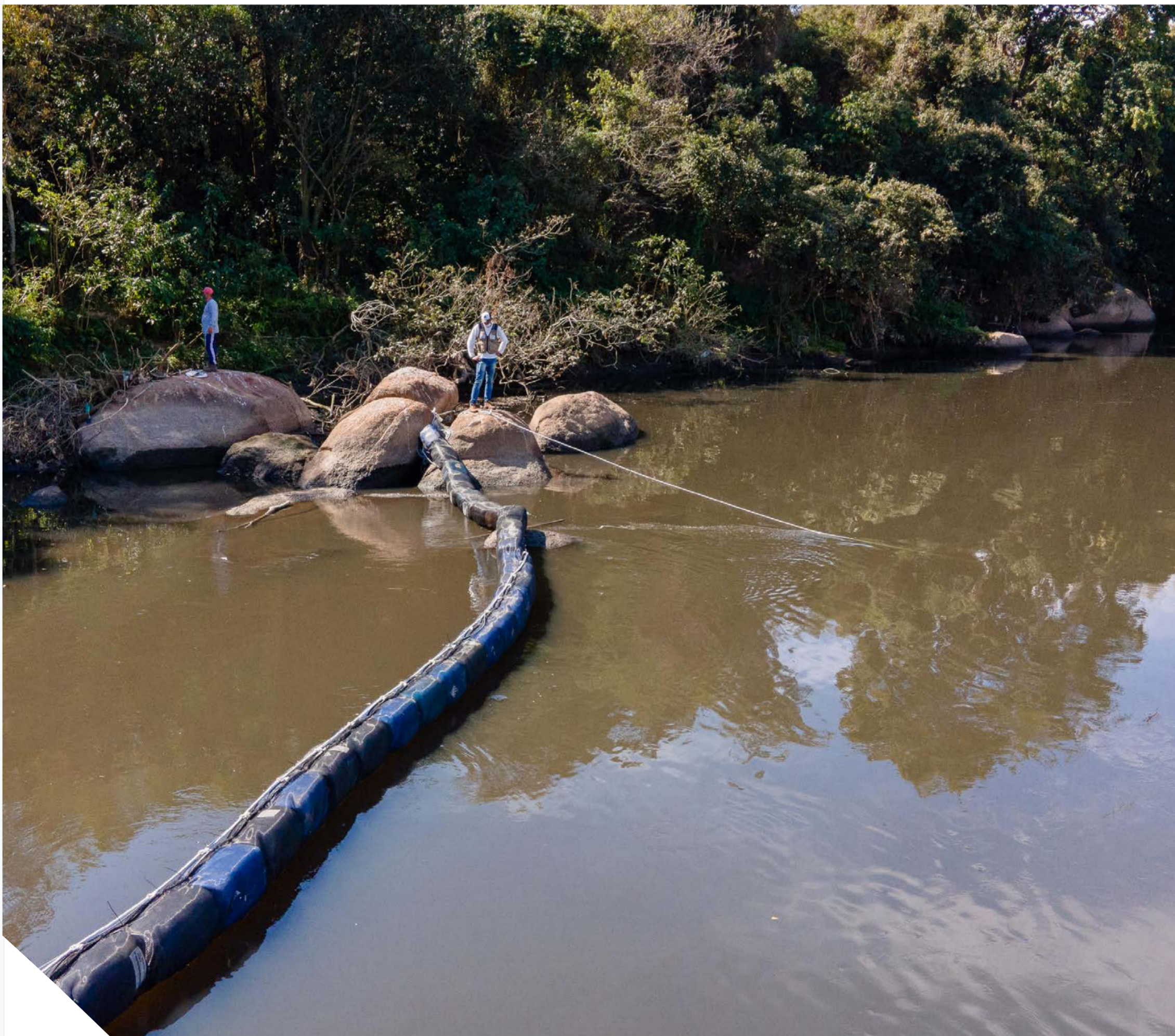
Ecobarreira montada no Parque de Lavras - Salto/SP
