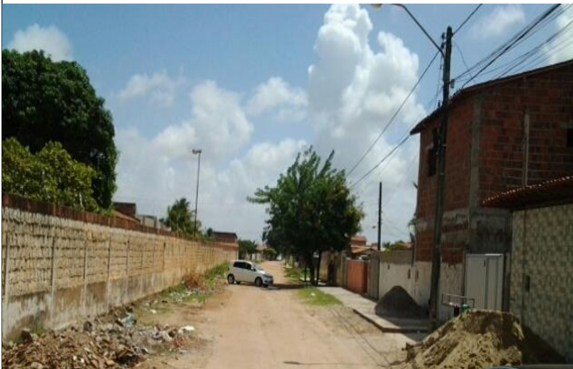
Situação atual da Rua Nilo Monentengro, uma das ruas a que a empresa Cabo Branco Hotelaria ficou obrigada a pavimentar e drenar.
